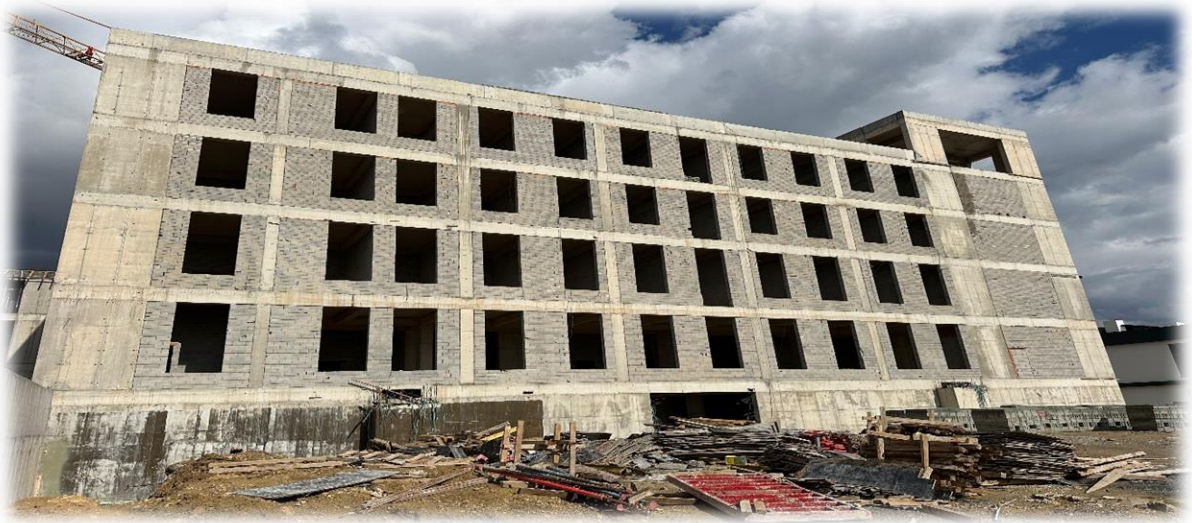
Sağlık Kampüsü Ortak Derslik Binası İnşaatı
