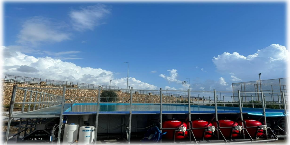
Kestel Yerleşkesi Portatif Havuz Kurulumu
