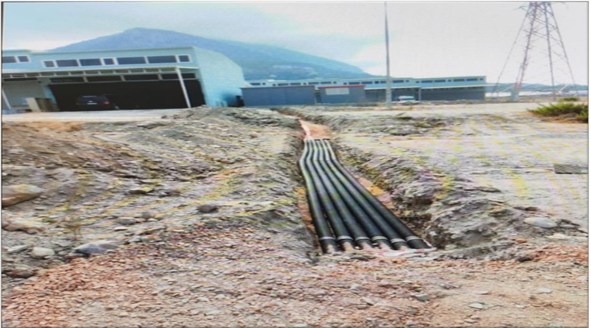
ALKÜ Bünyesindeki Yerleşkelerde Zayıf Akım ve Kuvvetli Akım Elektrik Altyapı İmalatlarının Yapılması İş
