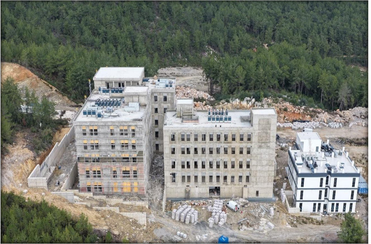
Sağlık Kampüsü Ortak Derslik Binası İnşaatı 2025
