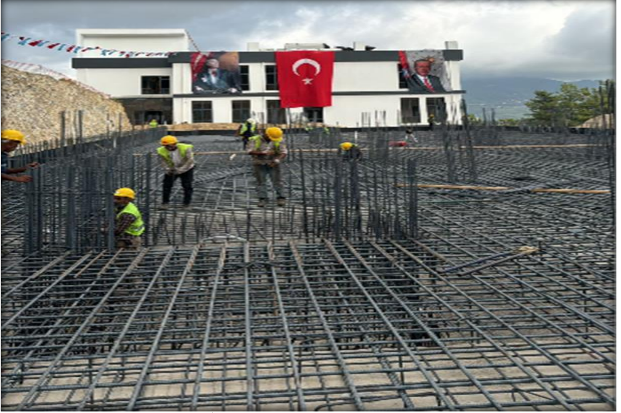
Sağlık Kampüsü Ortak Derslik Binası İnşaatı 2024
